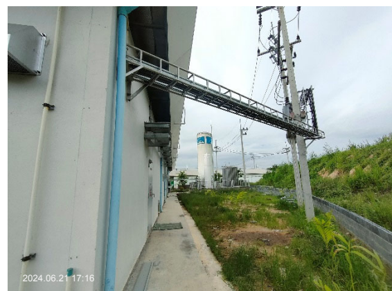
จัดทำรางเก็บสายไฟสำหรับระบบท่อส่งก๊าซธรรมชาติ เพื่อความปลอดภัยและความเป็นระเบียบเรียบร้อย
