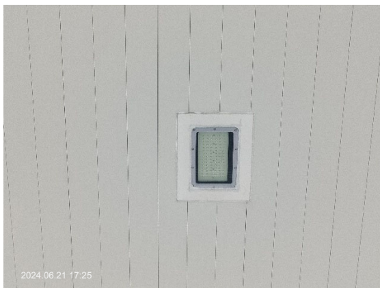
ติดตั้งระบบไฟฟ้าที่ใช้ภายในสถานีบริการเป็นชนิดป้องกันการระเบิด (Explosion Proof) (ต่อ)
