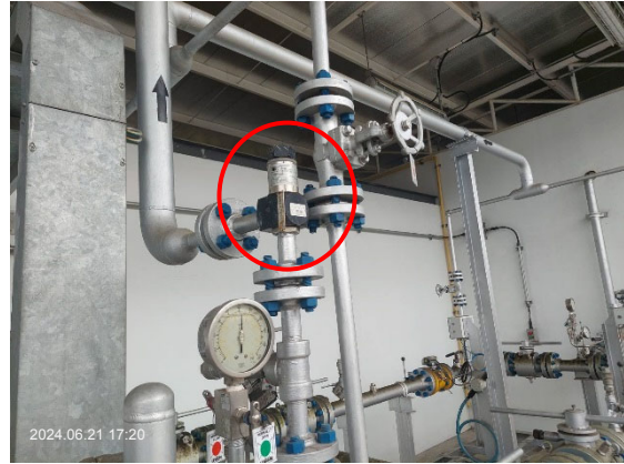
ติดตั้ง Safety & Relief Valve บริเวณอาคารควบคุม ความดันและวัดปริมาตรก๊าซ (Metering Room)
