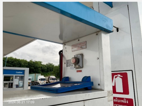
ติดตั้งสวิทช์หยุดการทำงานเมื่อมีเหตุฉุกเฉินไว้บริเวณหัวจ่ายก๊าซธรรมชาติ และบริเวณตู้จ่ายก๊าซธรรมชาติ
